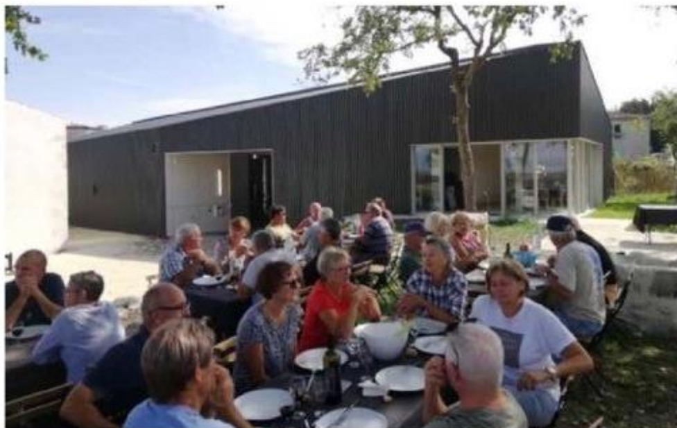
Après sept ans d'attente, de recours, le chantier a pu être lancé en février 2019. Achevé fin août, le chai connaît ses premières vendanges cette semaine. PHOTOS R. C.
